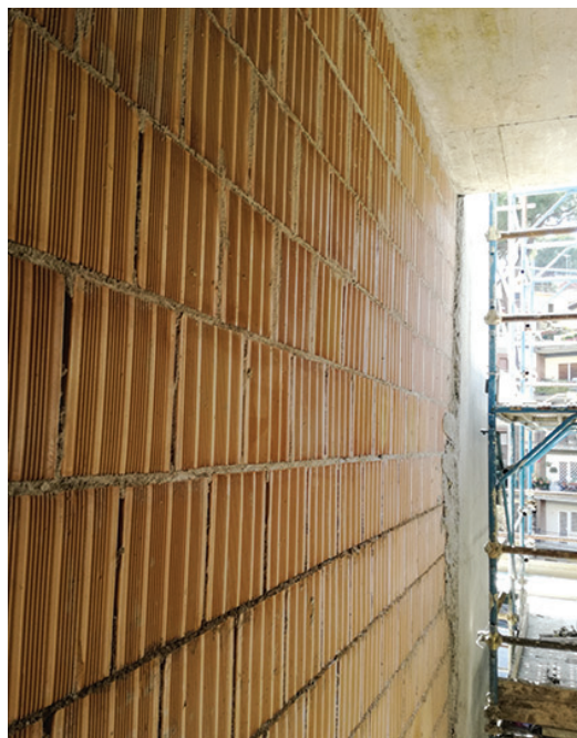
Fig. 8 - Fasi di posa in opera del sistema TRIS®, pareti vano scala.
