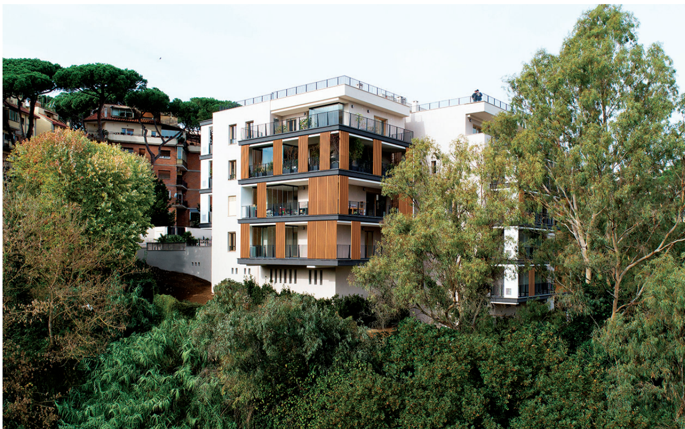
Fig. 18 - Vista sud-est della realizzazione. [©SiTerra]
