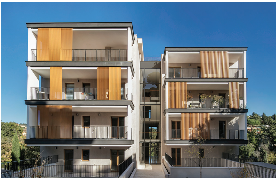
Fig. 13 - Fronte principale: particolare del taglio trasparente centrale che contiene ingresso e ballatoi. [©Luigi Filetici]
