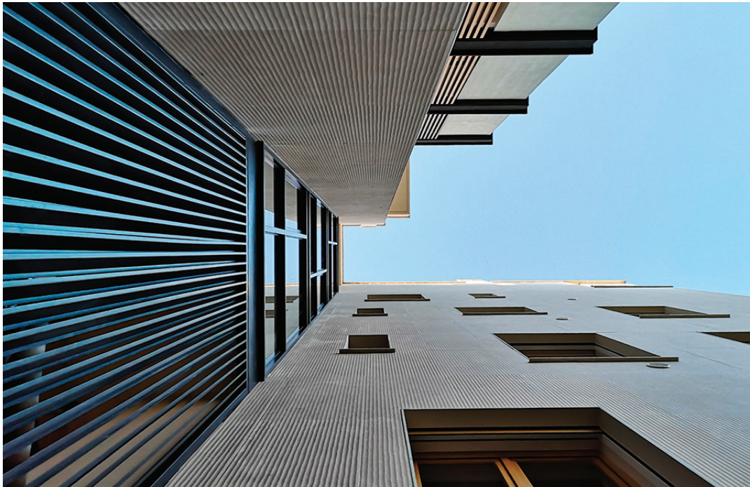
Fig. 12 - Finitura in grès dell'involucro perimetrale. [©Insula]
