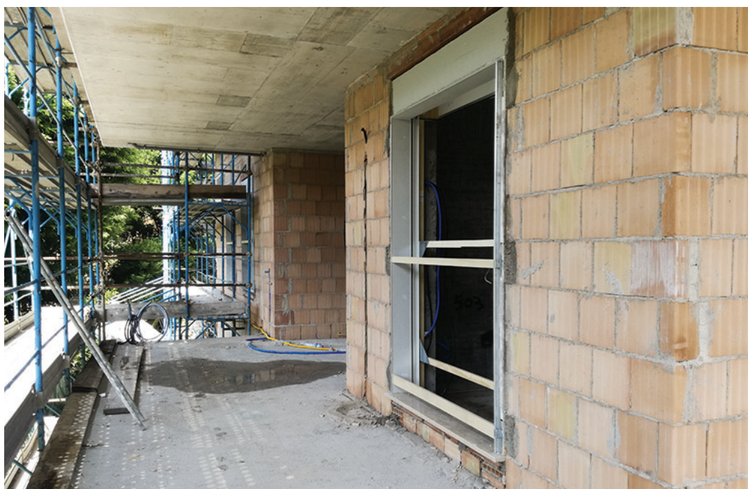
Fig. 9 - Fasi di posa in opera del sistema TRIS®, pareti esterne.
