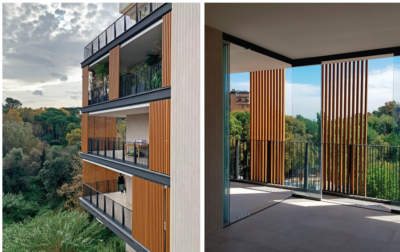
Fig. 16 - I balconi a sbalzo che caratterizzano l'edificio. [©Insula]
