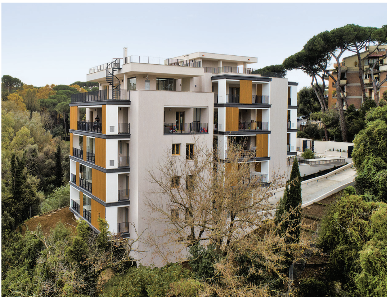
Fig. 1 - Vista nord-est della realizzazione. [©SiTerra]
