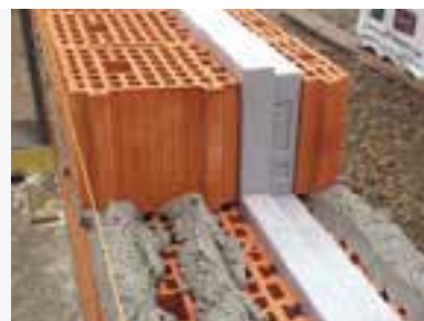
POSA IN OPERA ELEMENTO BASE
