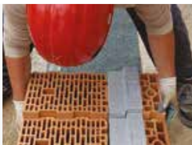
POSA IN OPERA ELEMENTO BASE
