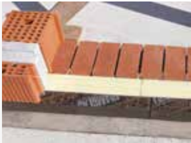
PREPARAZIONE DEL PIANO DI POSA
