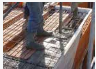
GETTO DEL SOLAIO
