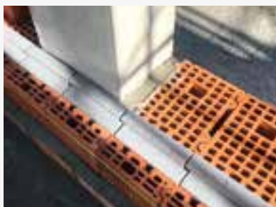
COIBENTAZIONE DEL PILASTRO CON COPRICORDOLO
