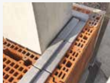
COIBENTAZIONE DEL PILASTRO CON COPRICORDOLO
