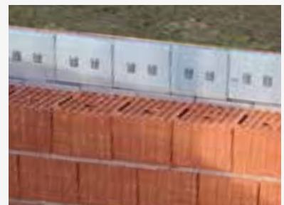
FUNZIONE CASSERO DEL SOLAIO
