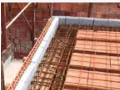
FUNZIONE CASSERO DEL SOLAIO
