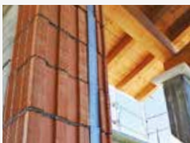
SPALLETTA DI PORTA
