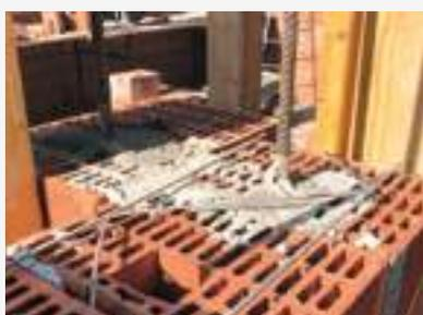
ARMATURA ORIZZONTALE CON TRALICCIO TIPO "MURFOR"
