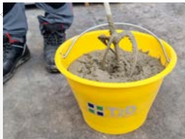
PREPARAZIONE DELLA MALTA
