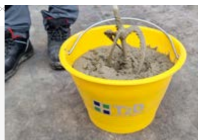
PREPARAZIONE DELLA MALTA
